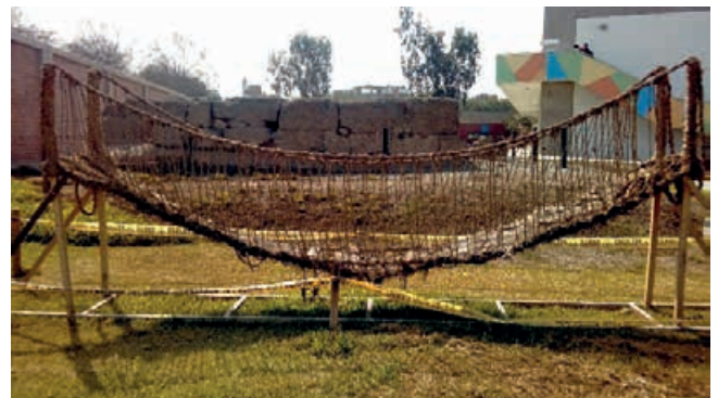
Figura 1. Puente colgante fabricado en ichu. Fuente: Elaboración propia.
